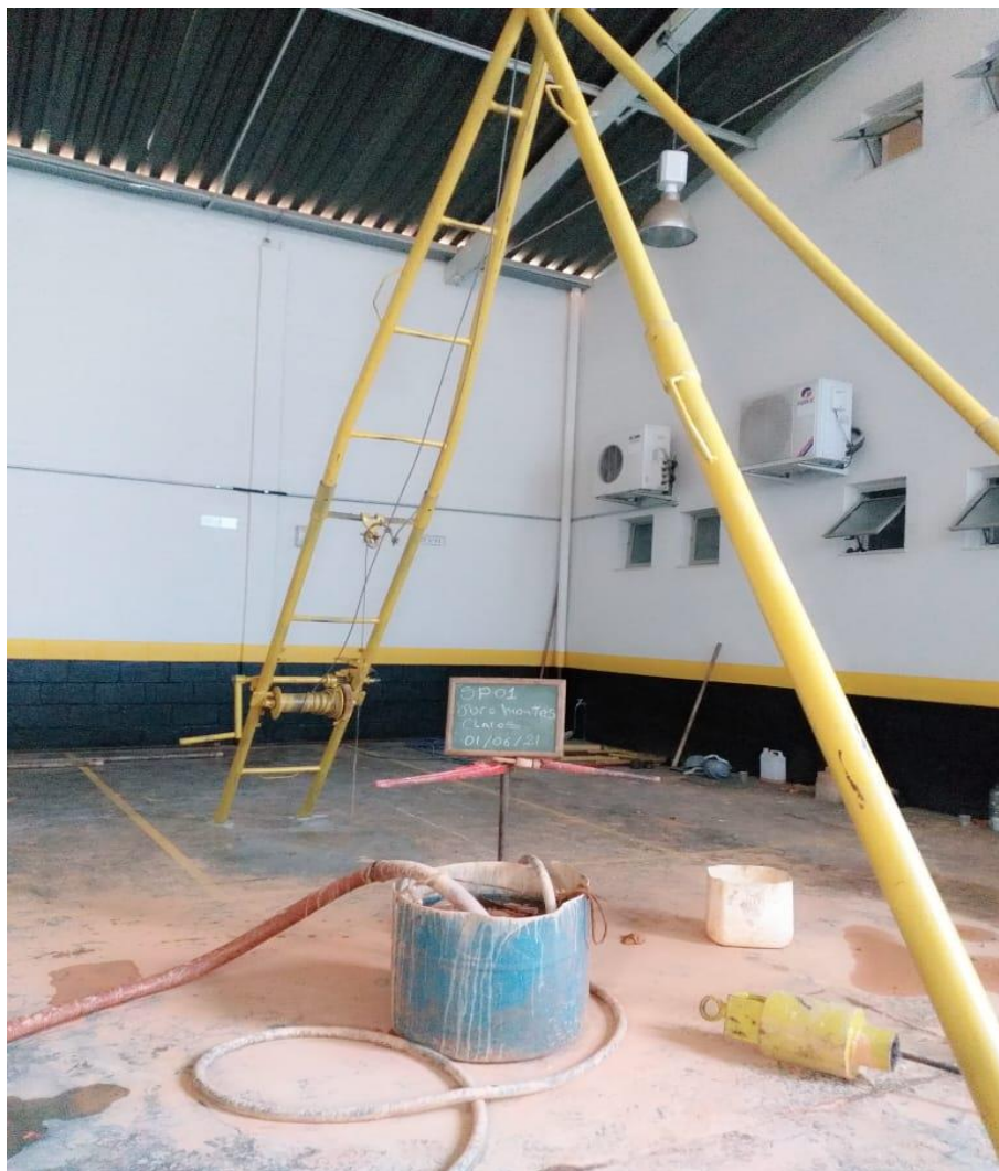
Instalação do furo SP-01
